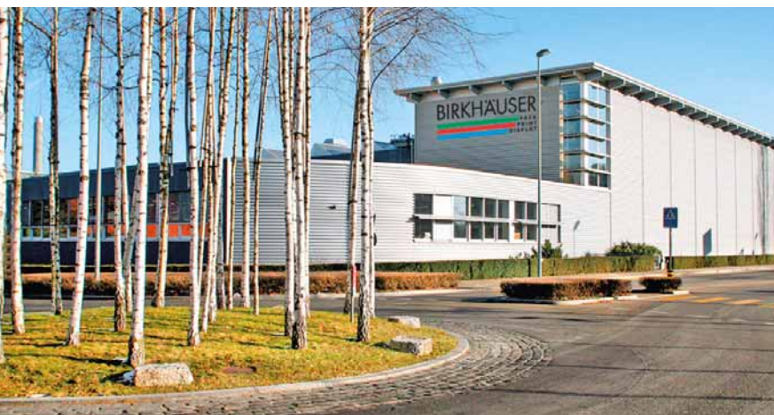
Das Firmengebäude von Birkhäuser+GBC in Reinach bei Basel
