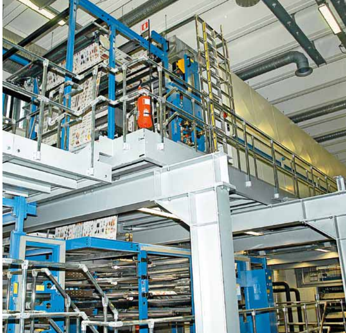
Vista del forno di essiccazione heatset nella sovrastruttura
