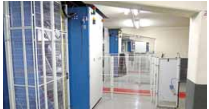
Genau eingepasst in die vorhandene Halle wurden auch die Rollenwechsler, die aufgrund der Rollen- bzw. Hülsendimensionen der dreifachbreiten Rotation mit den vorgeschriebenen Schutzgittern ausgestattet sind
