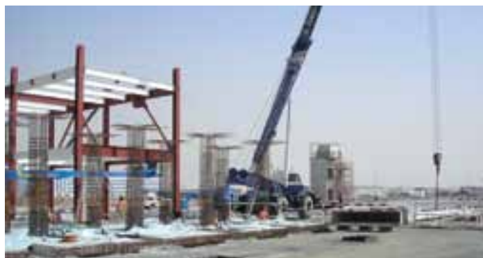
Baubeginn für das neue Druckzentrum von Al Nisr Publishing im Industriegebiet Dubai Investment Park, Green Community, rund 60 km außerhalb von Dubai-Stadt
