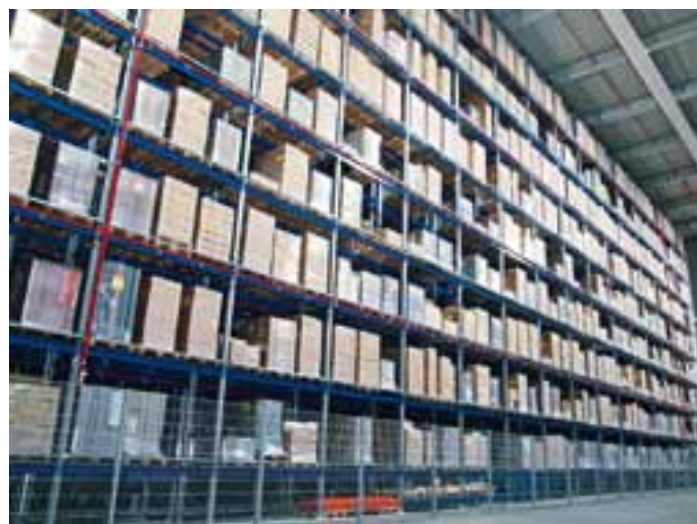
Le magasin entièrement automatique d'une surface de 5000 m 2 a été construit entre mai 2010 et juillet 2011. Il permet le stockage de 7200 palettes de produits finis et flans
